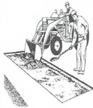
ازالة التشقق حتى الوصول الى التربة
